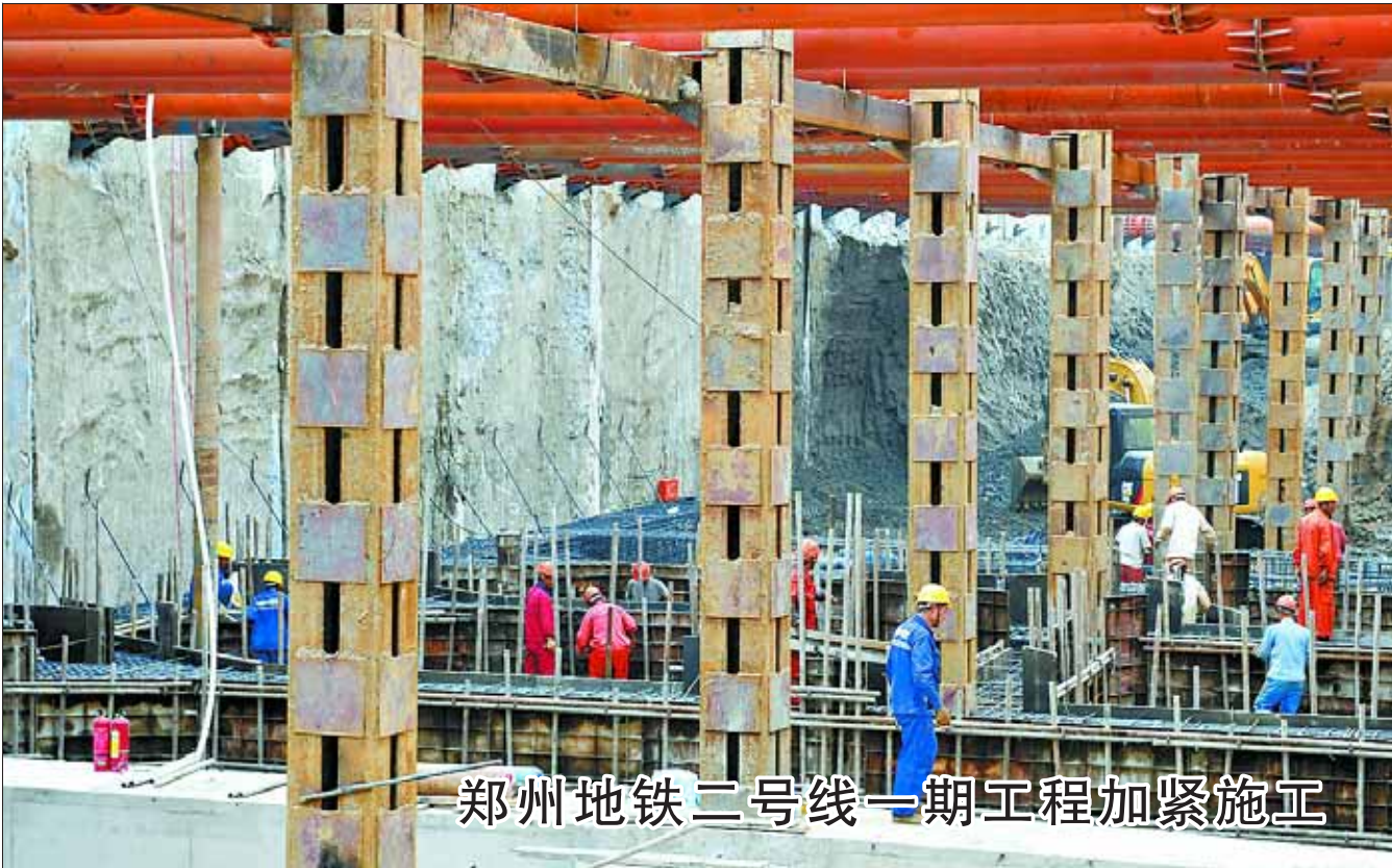
目前,由中国中铁股份有限公司总承包的郑州市地铁2号线一期土建工程正在紧张进行中。郑州地铁2号线一期工程起于广播台站,止于南四环站,全长20.655公里,共设车站16座,预计于2015年底实现开通试运营。 图为6月18日,在郑州地铁2号线黄路站,中铁隧道局的工程人员在施工现场作业。
