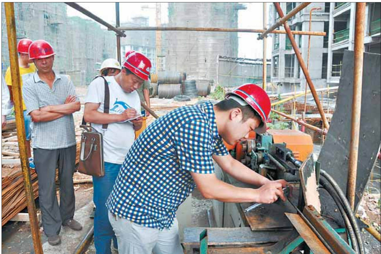
近日,淇县住建局组织开展了“瘦身钢筋”质量大检查活动。截至目前,共检查社区、水厂等20多个项目,未发现在建项目存在使用“瘦身钢筋”现象。 侯中民 牛平昌 摄
