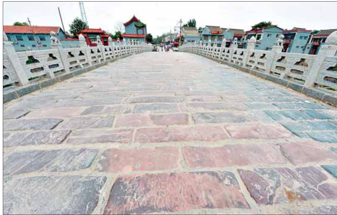
修建于明代的云溪桥桥面。
