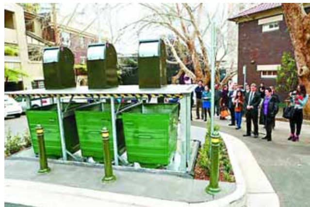
罗伊斯顿街的废弃物地下积存系统试点。
