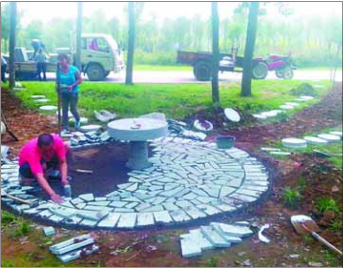
淇滨区园林局加大沿淇公园基础设施建设力度,投资近10万元,在淇水诗苑、淇水乐园新建10套石桌、石凳和园路,以方便游人观光和休憩。截至8月23日,10套石桌、石凳和园路已建设完毕。
