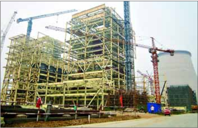
图为正在建设的锅炉（左边）、汽轮机钢构。
