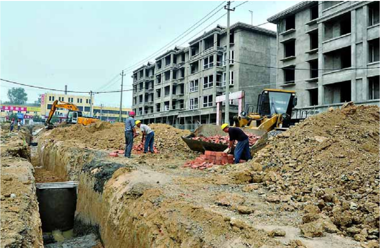
近日，鹤山区落实解决第一批整改事项，中山小学门前教场街作为第一批整改事项正在整修中，预计10月底完成。
