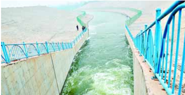
图为南水北调中线总干渠的水向淇河奔涌而去。
