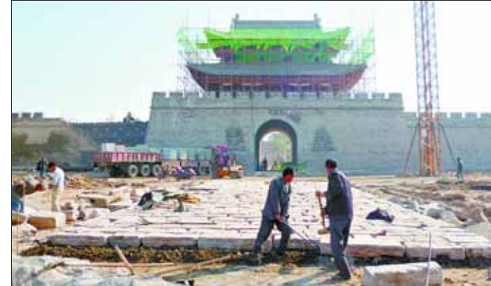
总投资约26亿元的浚县古城保护与旅游发展项目,规划范围2.1平方公里,建设内容包括古城肌理保护修复、运河遗产文化带、黎阳仓国家遗址公园等22个项目。图为正在复建的西城门,目前主体已经建成,城楼正在进行油漆彩绘,城门外广场正在铺石。本报记者张心敬摄于11月7日
