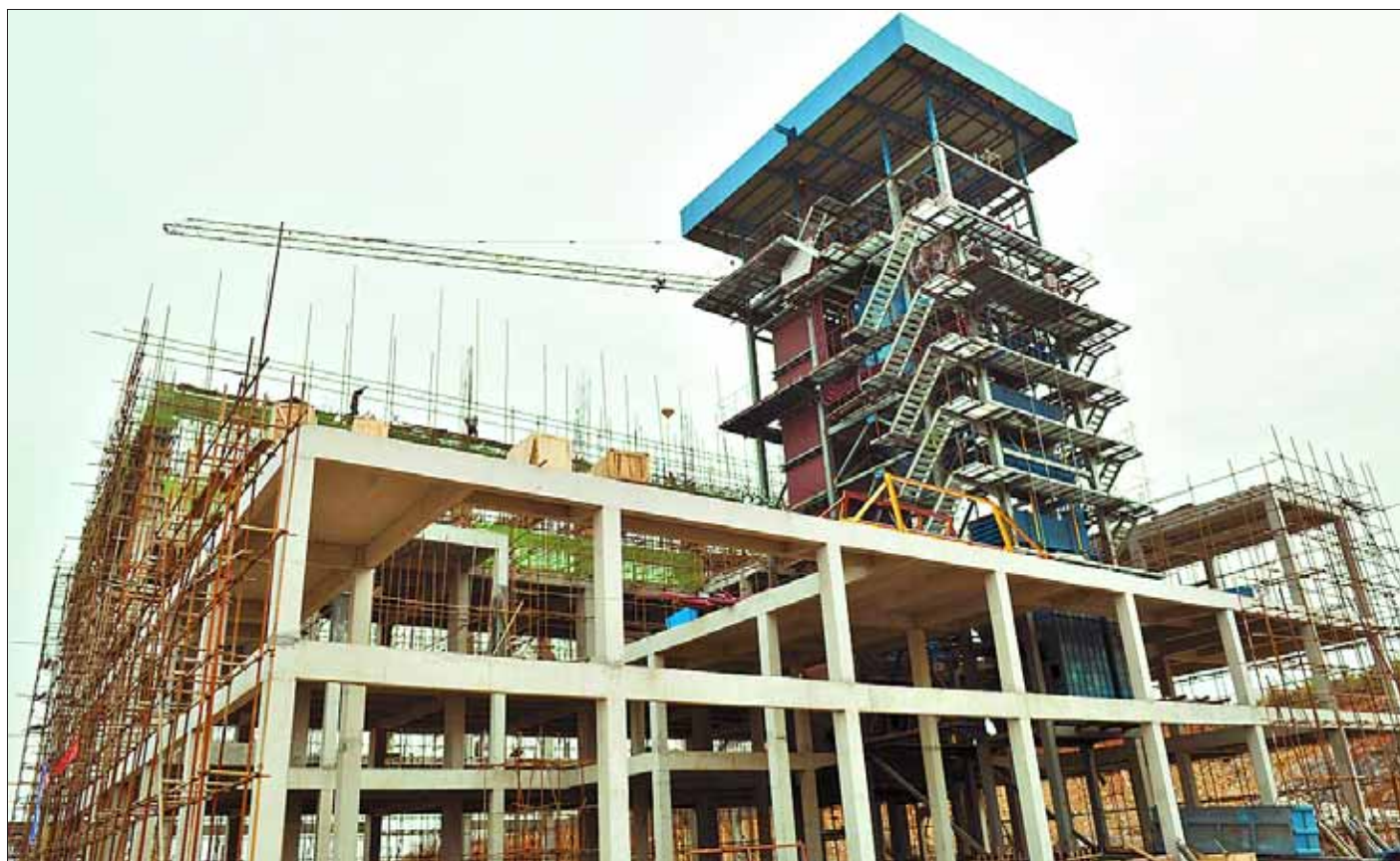
近期,鹤山区姬家山产业园区项目建设进展迅速。目前,鹤壁鼎炬热能有限公司热电联供项目的办公楼已封顶,水处理车间地基已完成,主厂房锅炉主体设备已安装,正在安装辅助设备,预计今年年底竣工并投入试运行。图为鼎炬热能公司项目建设现场。 毕燕周 摄
