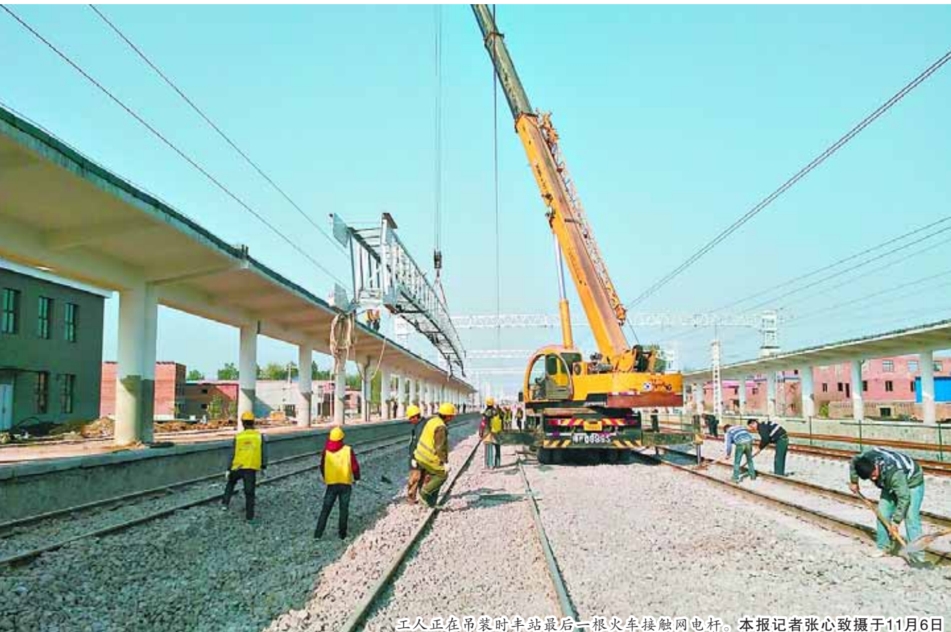
工人正在吊装时丰站最后一根火车接触网电杆。本报记者张心致摄于11月6日
