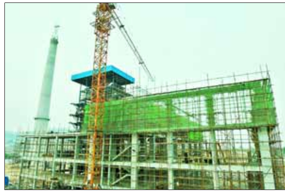
图为项目建设现场。
