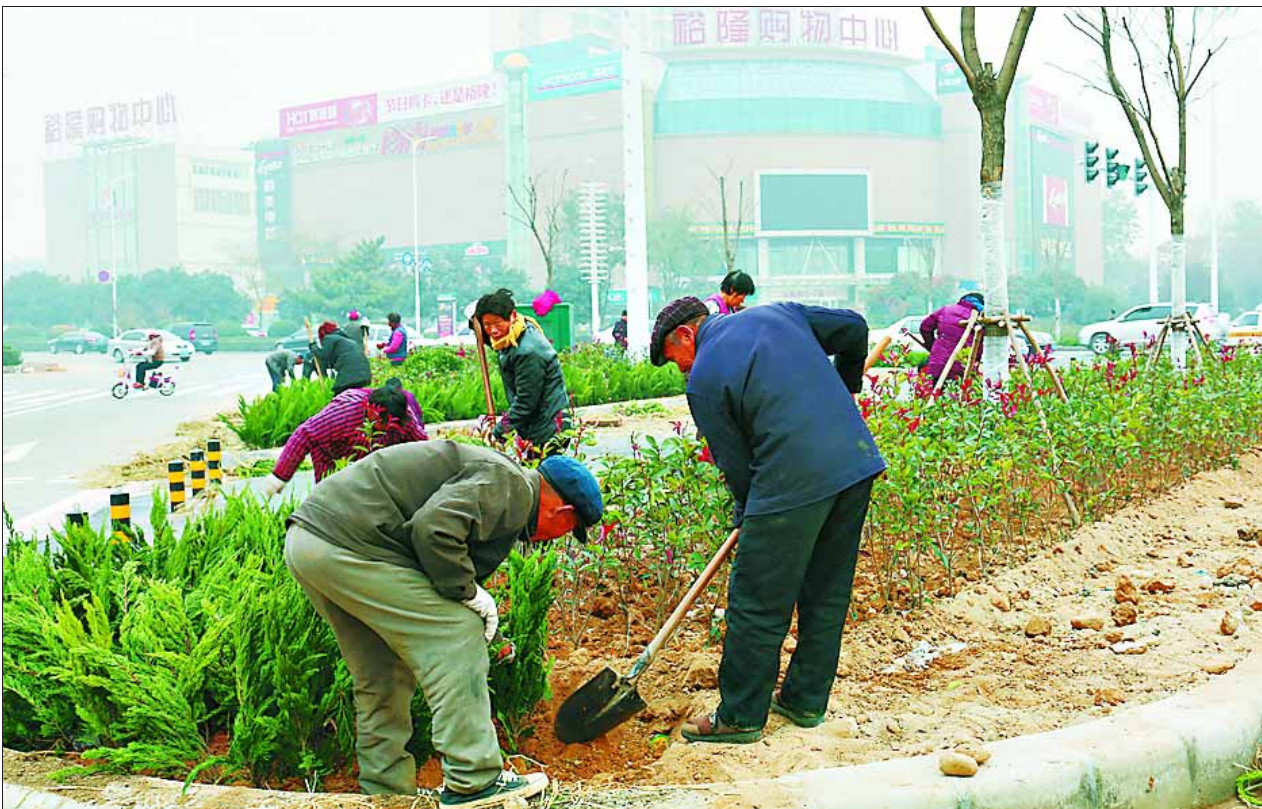
淇滨区加快兴鹤大街与淇滨大道交叉口交通分流岛绿化工程建设,提升城市品位。该工程绿化面积750平方米。图为日前该区园林局职工种植龙柏、石楠、白蜡等景观苗木。牛军旗 摄
