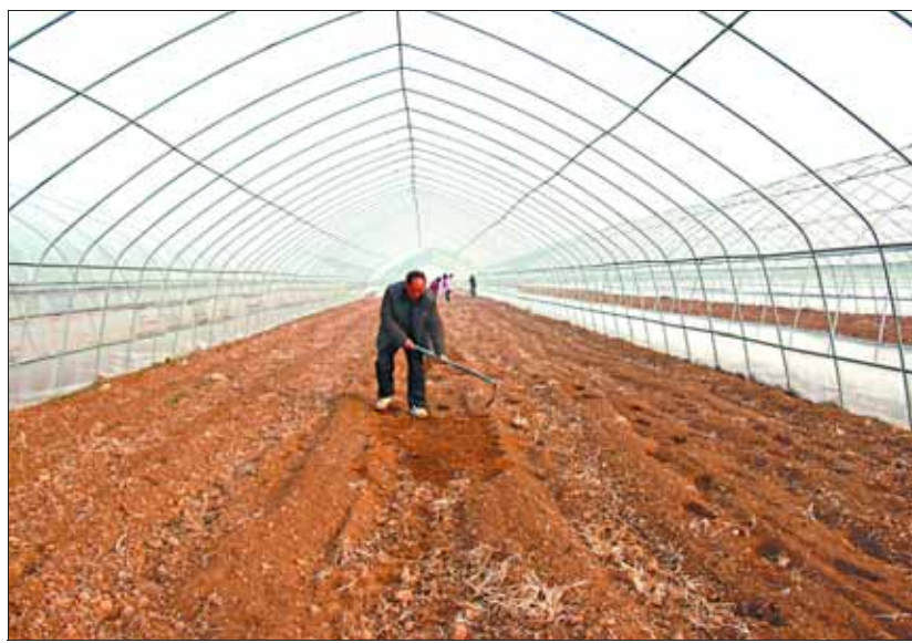
日前,浚县东丰蔬菜农业标准化示范区的工人们正在新建的标准化钢管大棚内平整土地。 徐朝广 摄
