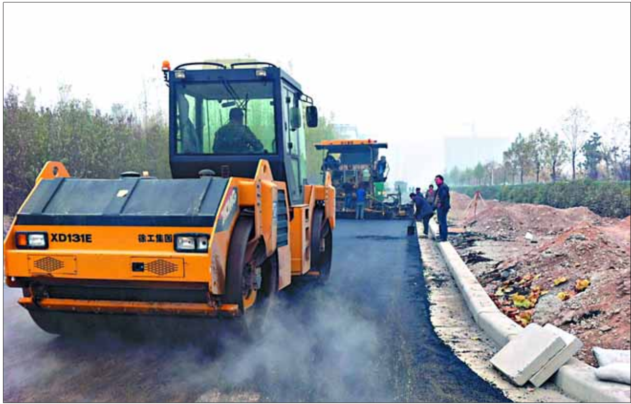
为加快城市道路建设,淇县积极组织开工建设卫都路北延、淇河西路、泰山路西延3条市政道路工程。目前,卫都路北延、淇河西路已通车,泰山路西延正在铺设油面。 余海洋 摄
