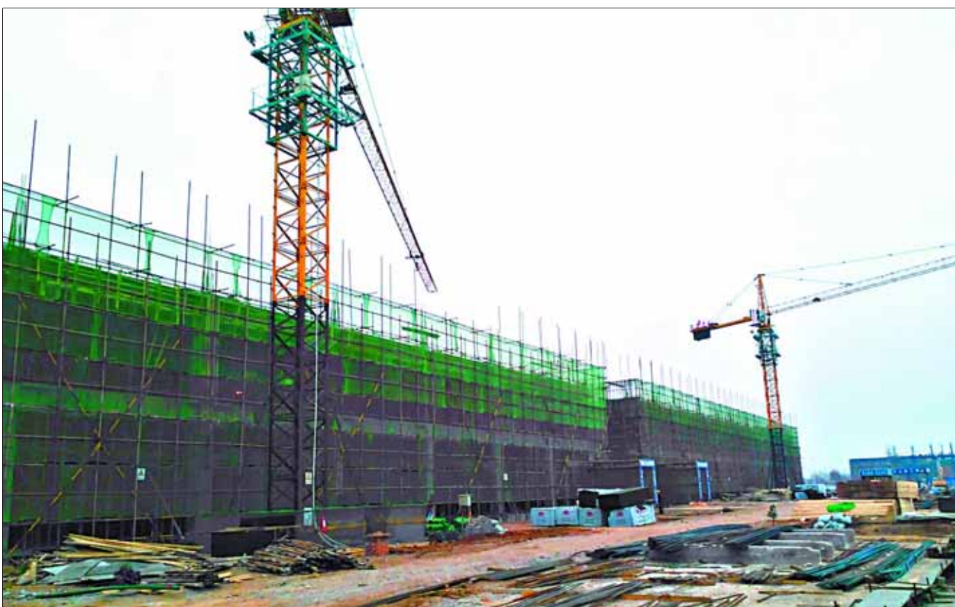
荣兴电子科技园项目正在建设的两栋厂房。
