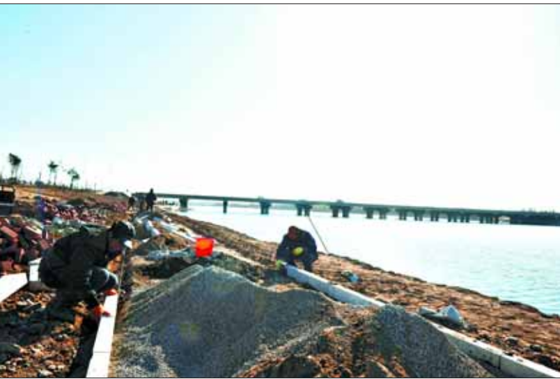
位于市城乡一体化示范区中部、鹤淇大道淇河桥西侧的淇川樱花园项目是淇河生态风貌带的重要景点之一,目前该景观人行道正在施工,预计本月底可完工。 本报记者 郭艳广 摄
