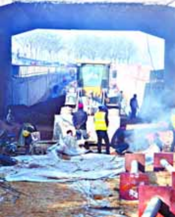
东大线京广铁路桥段施工现场。本报记者 李鹏 摄
