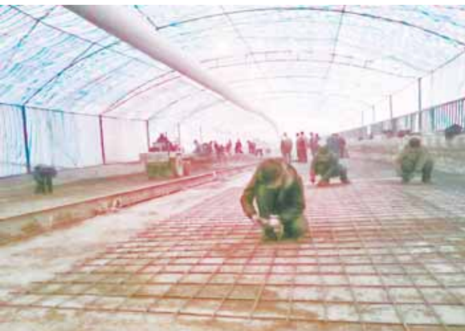
图为工人们正在工棚内铺混凝土路面和绑扎钢筋网。
