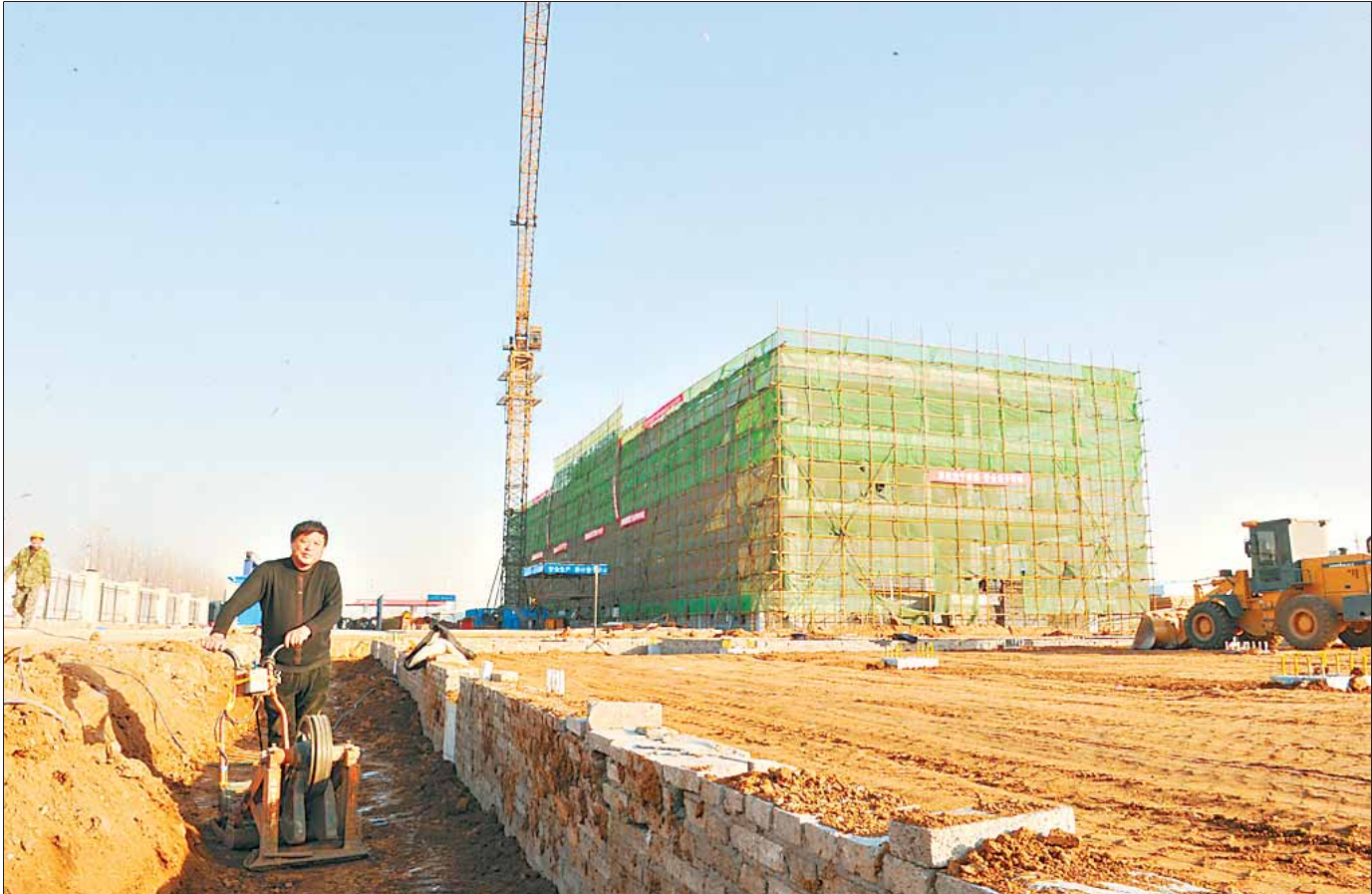
总投资9.5亿元的鹤壁西联通信技术有限公司年产3000万套IT通信和智能终端产品项目位于鹤壁国家经济技术开发区城北工业园区,产品包括智能DNS设备、储存设备、路由器、蓝牙耳机等。项目分3期建设,一期预计到2015年7月底建成投入使用。图为工人在一期项目工地填埋地基土料,以增强地基的抗震能力。
