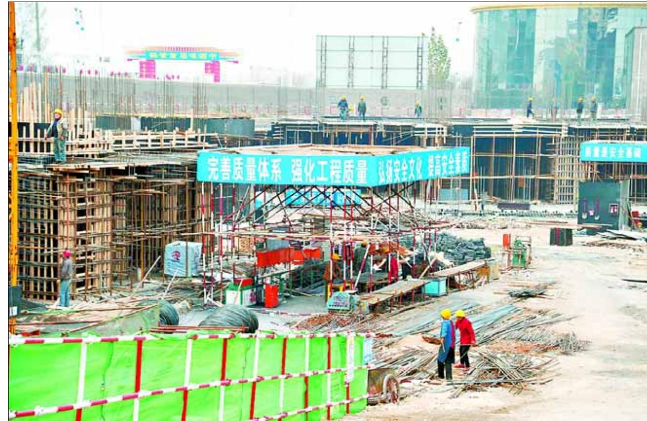
2014年12月24日,位于市商务中心区的天津渤海交易大厦在加紧施工。该项目总投资3.5亿元,建筑面积7.2万平方米。项目建成后,将为我市企业提供全方位、全过程、一体化的技术信息和网上交易服务。截至目前,该项目主楼和1号楼正在进行负一层模板安装,2号楼正在进行负一层混凝土浇筑,3号楼正在进行地上一层钢筋绑扎。
