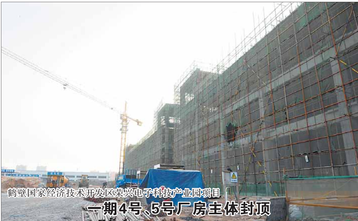
鹤壁国家经济技术开发区荣兴电子科技产业园项目一期4号、5号厂房主体封顶
