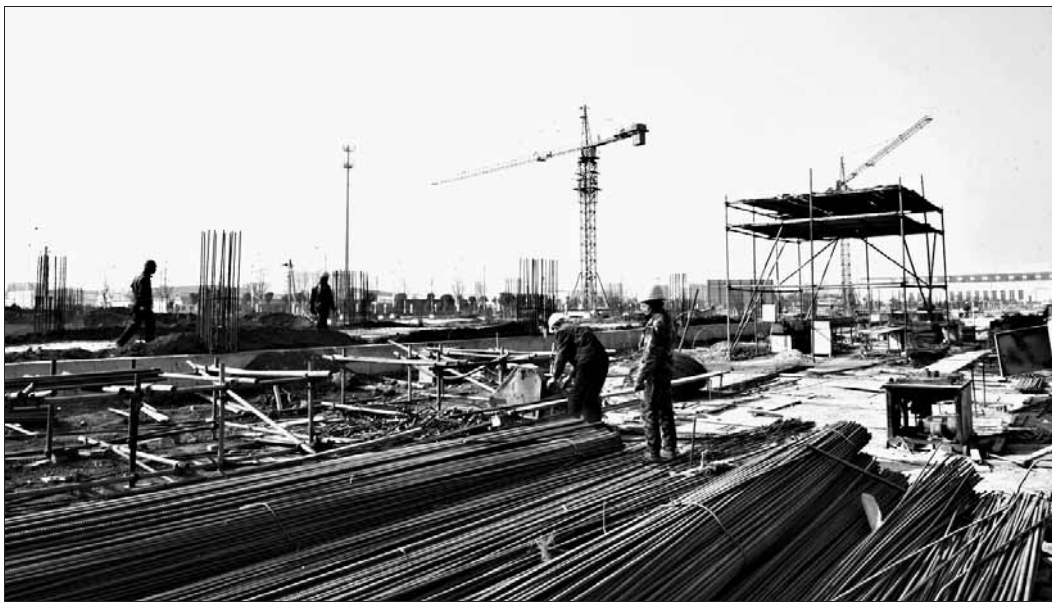
春节临近,华塑集团泓天雨(鹤壁)高分子新材料产业园的建设工人仍在工地忙碌。该项目是市招商引资重点项目之一,产业园内总投资10亿元、专业生产BOPA高阻隔薄膜的河南信德塑业有限公司和总投资17亿元、专业生产TFT-LCD用偏光片光学保护膜河南弘宇光电子材料有限公司。项目一期建设一栋5层综合楼已封顶,3号生产厂房已完工,1号和2号生产厂房地基建设基本完工。
