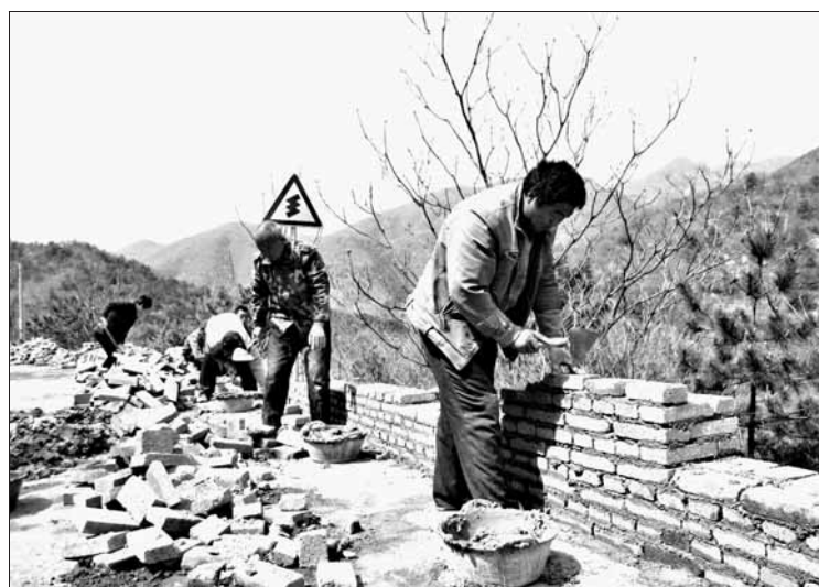
近日,淇县黄洞乡通往封王殿村的道路上,工人正在修筑道路护栏。据了解,该路段长约10.5公里,多为盘山公路,道路一侧多深沟、悬崖。为了保障村民出行和交通安全,黄洞乡政府去年就开始协调有关部门进行施工,目前已完成施工7公里。
