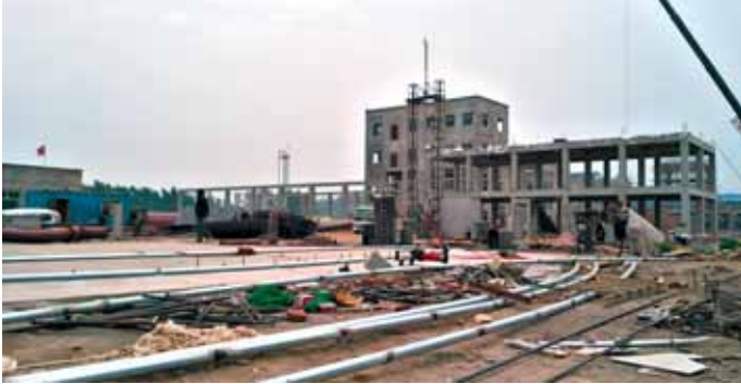
图为项目施工现场
