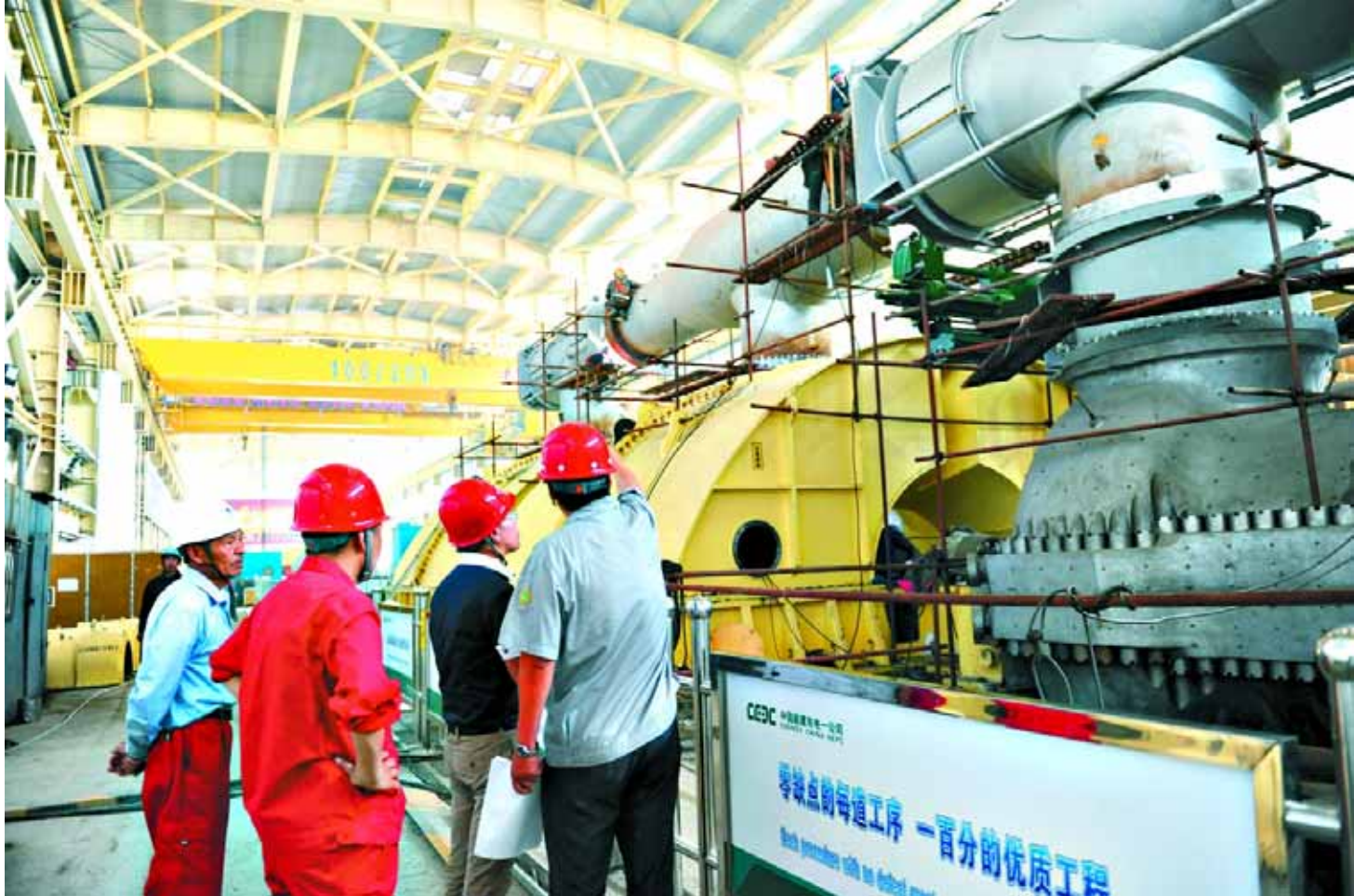
图为工人在安装汽轮机设备
