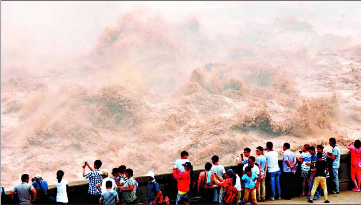
黄河“调水调沙”是迄今为止世界水利史上最大规模的调水调沙原型人工试验。从2002年开始，黄河开始实施调水调沙，依靠黄河小浪底水库等大型水库的人工调节，制造出冲刷下游河床泥沙的人造“洪峰”，输沙入海。黄河“调水调沙”目的是解决这条世界闻名的“悬河”的泥沙淤积问题。图为游客在黄河小浪底水利枢纽工程出水口观看泄水时的壮观场景。
