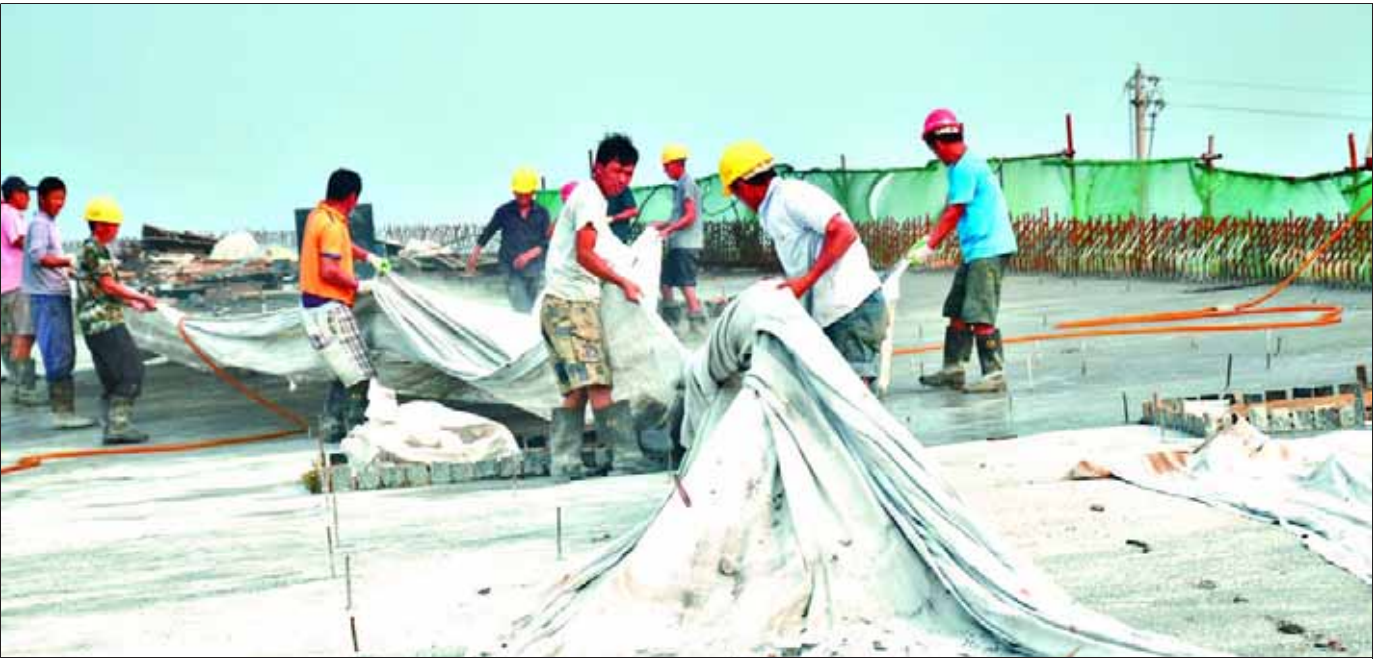
8月4日，鹤辉高速公路古城立交桥800多米桥面主体已完工。目前，鹤辉高速公路已完成路基挖方784万立方米、涵洞通道148座、桩柱2006根，占总工程量的80%以上。图为工人正在用布料覆盖桥面，随后给桥面浇水，保持湿度，防止桥面被晒裂。
