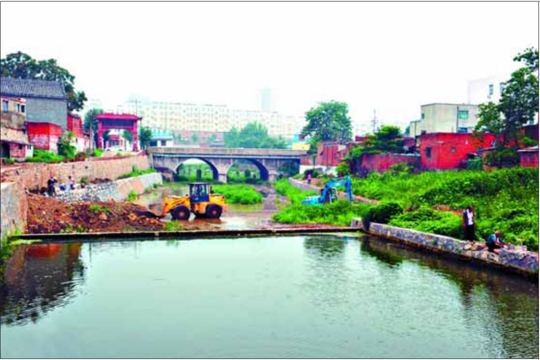
8月6日，工作人员在汤河山城区陈家湾段进行清淤、河堤砌护。
