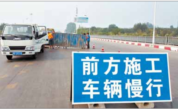
8月8日,我市市区公路管理局的维修人员在107国道淇河公路大桥上搭建施工护栏,对破损的桥面进行维修。施工人员介绍,他们使用的水泥凝固期需28天,在施工处设有施工标志,希望通过施工段的车辆减速慢行。 本报记者 李国庆 摄
