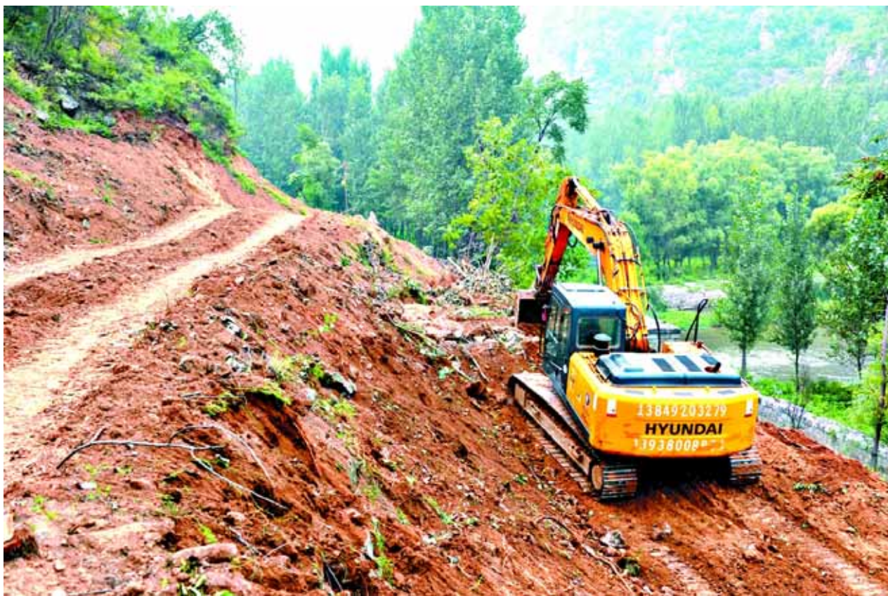
8月20日,鹤山区西部山区旅游环线建设工程正在加紧施工。目前,杨家庄至施家沟、蒋家顶至李家顶路段已完工通车,张家沟至施家沟路段建设过半,李家顶至老望岩、李家顶至东齐、张家沟至老望岩路段正在进行路基施工,整个工程预计年底前完工。图为李家顶至东齐路段施工现场。(张付霞 摄)
