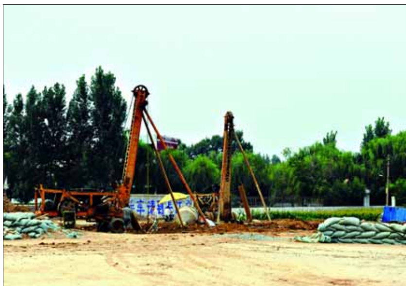
8月20日,冯岗沟桥梁在建项目正进行盖梁施工。该工程位于兴鹤大街和松江路交会处,桥长16米,宽60米、高2米,是鹤壁国家经济技术开发区侯小屯村至市区的重要通道。工程预计今年10月中下旬完工。 本报记者 郭艳广 摄
