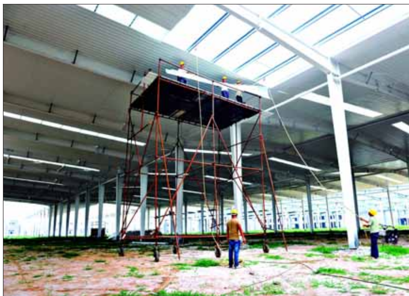
日前,天海国际高端线束出口工业园二期项目主体建设进入收尾阶段。该项目位于鹤壁国家经济技术开发区城北工业园区,总投资10亿元,主要建设汽车高端线束、冲压模具生产线等,二期在建项目包括一栋4.6万平方米的办公楼和一座8万平方米的钢结构厂房。图为工人在加紧安装车间顶棚。 本报记者 郭艳广 摄
