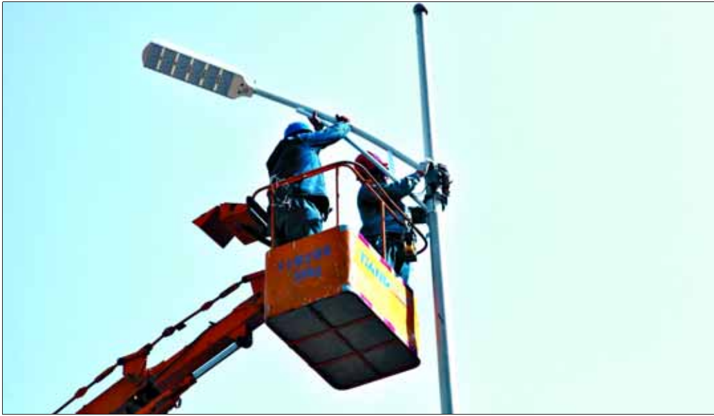
近日，淇县供电公司对其县城内老城区17条道路1191盏路灯进行全面升级改造，改造后的LED灯每年可节电115万千瓦时。图为技术人员正在安装新型节能LED灯。 郭瑾 摄
