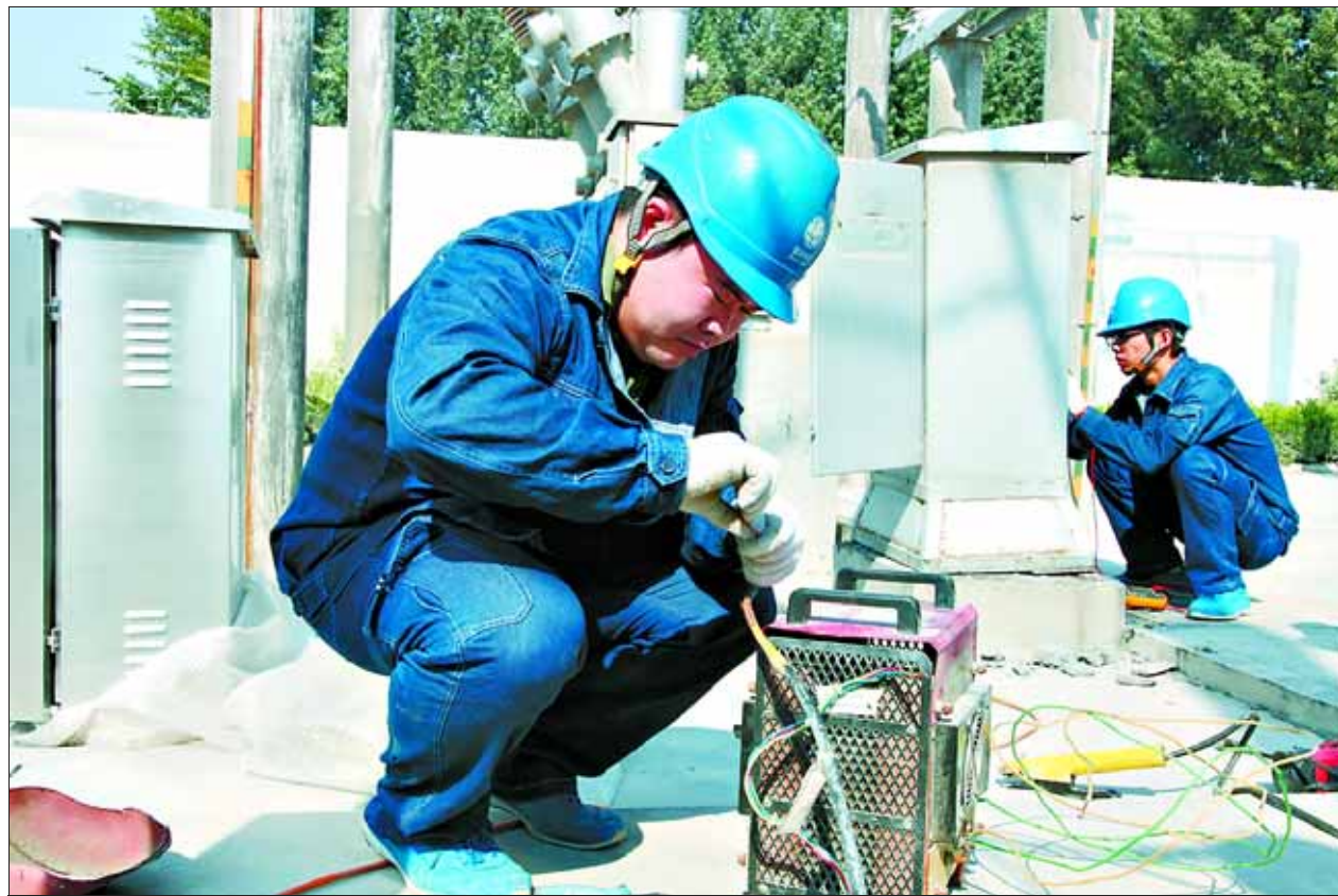
日前,淇县供电公司检修班来到35千伏董家变电站,对接线端子箱进行更换。据了解,为进一步提高设备运行稳定性,该公司还将集中更换潮歌变电站和庙口变电站共计18个接线端子箱,消除因设备老旧而造成的安全隐患。李淑媛 摄
