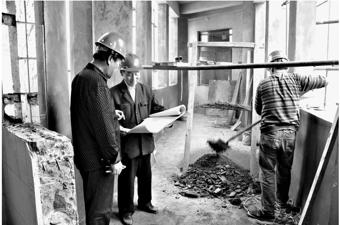
碗振现(中)在施工现场监督工程
