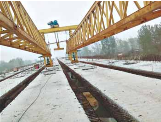
大海线浚县段淇河大桥正在架设箱梁 本报记者 李鹏 摄
