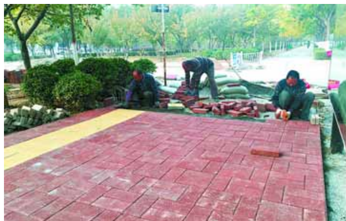
工人们正在进行人行道透水砖的铺装
