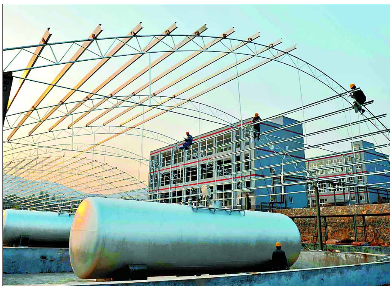
鹤山区狼抓园园区项目建设,目前,姬家山产业园区的鹤壁市海格化工科技有限公司年产10万吨离子交换树脂项目进展迅速,1号、2号、4号车间建成并完成设备安装,研发楼已建好并投入使用,5号车间正在安装设备,办公楼主体已建成,年底前完成路面硬化工作,主罐区16个罐已安装完毕,正在安装罐区辅助设施。图为近日拍摄的主罐区辅助设施安装场景。
