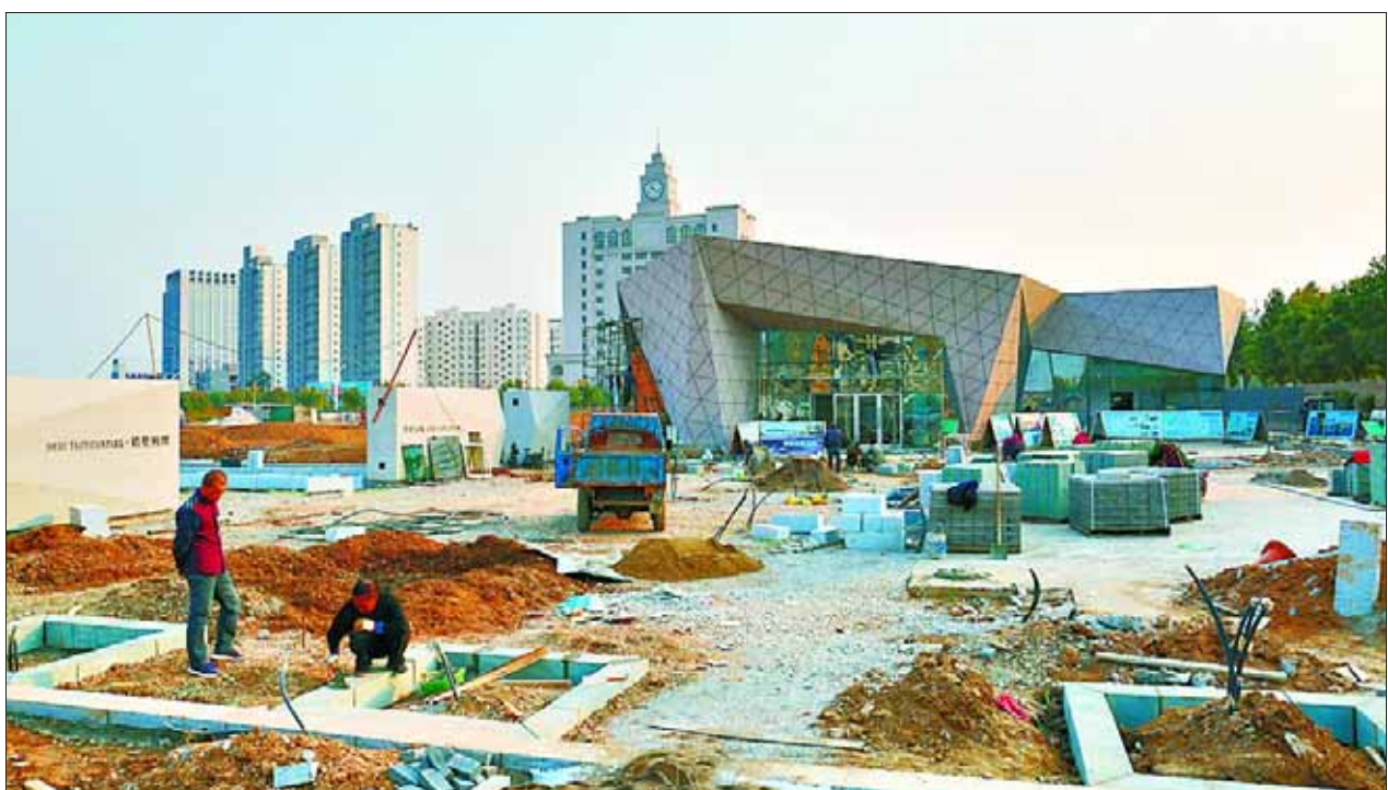
淇滨区快速推进桃园公园项目建设,目前,该项目已完成公园围墙、东西出入口、管理房等主体工程建设,水系工程正在施工,入口广场正在进行基础垫层施工。图为公园入口处施工现场。
