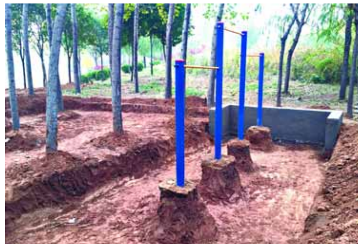
建设中的渗水沙池
