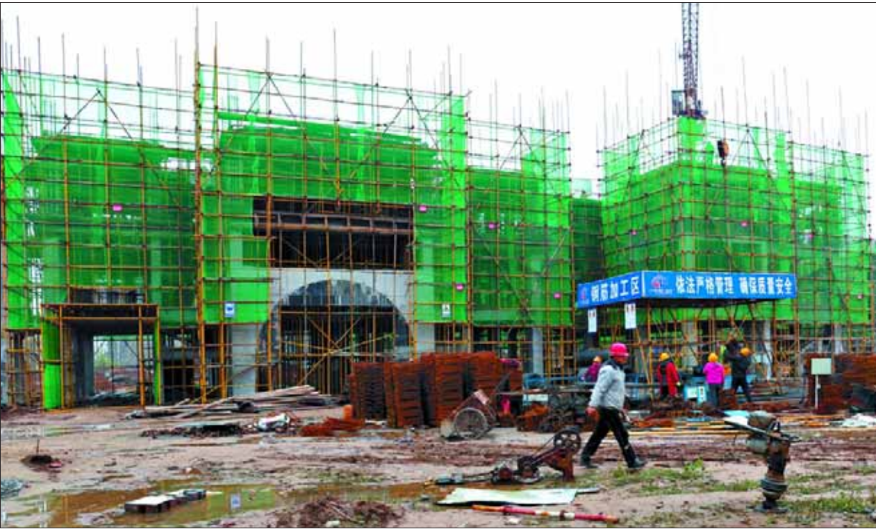
淇滨区加快天山小学项目建设,该项目位于天山路东、柳江路北,总建筑面积约1.2万平方米。目前,该项目实验楼主体已封顶;1号办公楼、2号教学楼正在进行四层建设,预计12月中旬主体完工;1号教学楼、2号办公楼正在进行一层建设,预计12月底主体完工。预计明年4月,该项目5栋楼主体完工,交付使用。
