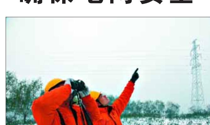
11月25日,鹤壁供电公司输电运检部门工作人员正在用红外测温仪对输电线路测温。
