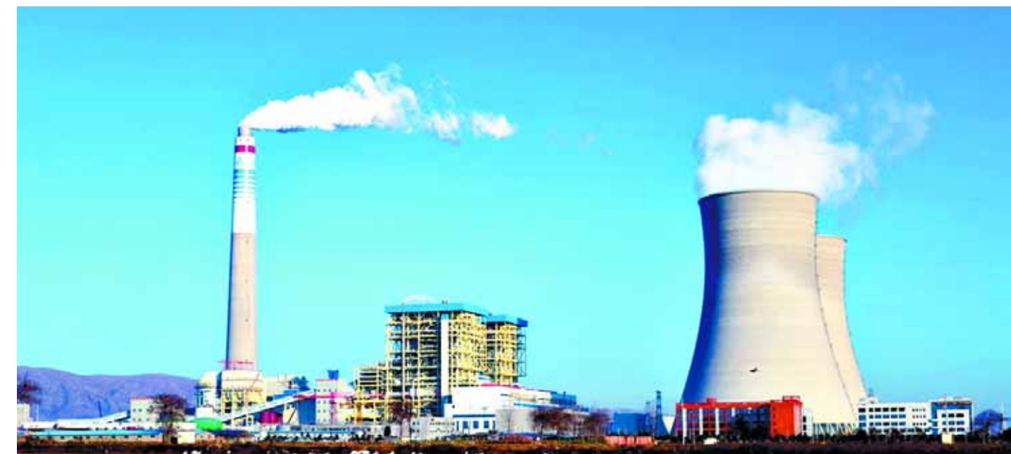
鹤淇电厂1号机组正式投产发电
