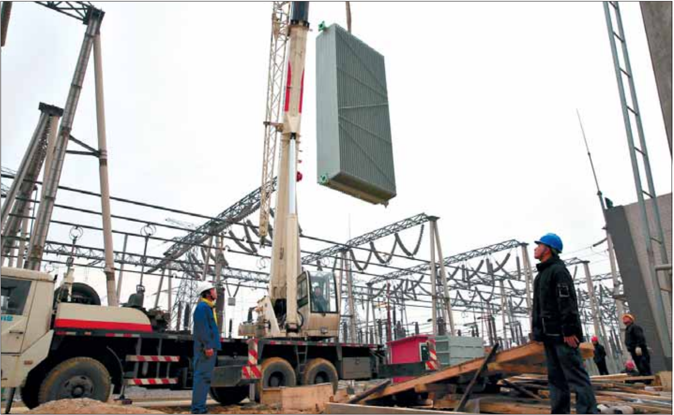
12月15日,在国网鹤壁供电公司220千伏衡山变电站2号主变扩建现场,施工人员抓住当前天气晴好的有利时机,不畏严寒,克服施工有效时间短等不利因素,每天7时30分至18时不间断施工,安装2号主变散热器,确保明年1月投入运行。2号主变容量为180兆伏安,可进一步增强鹤壁电网的供电能力,为迎峰度冬和春节用电提供坚强电力保障。
