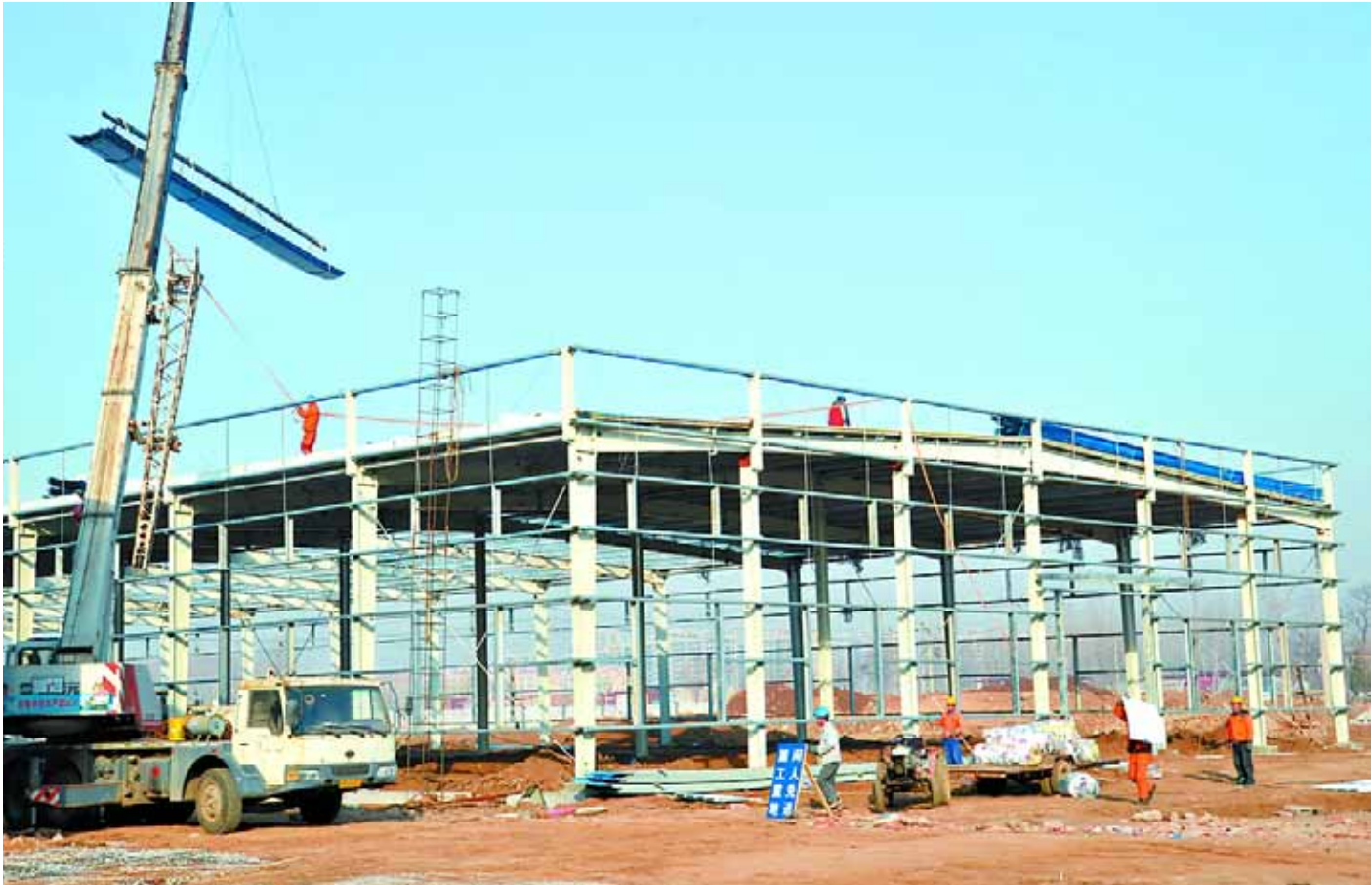
1月13日，鹤壁产业集聚区汽车配件园区内，河南亿网光电科技有限公司年产80万箱环保型数字通信电缆项目新厂区的8号厂房正在吊装顶板。该项目总投资7亿元，是香港金洋国际集团有限公司在内地投资的重点项目，主要生产符合欧盟环保标准的低烟无卤型通信电缆，产品出口英国、俄罗斯、越南、巴基斯坦、哥伦比亚等23个国家和地区。去年8月动工的新厂区主要建设工业厂房以及综合办公楼等配套设施。目前，5号、6号厂房主体已完工。
