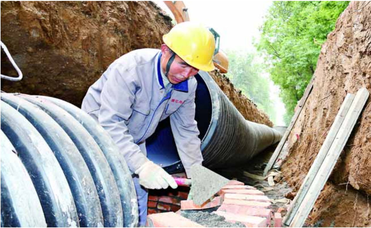
长风路大修工程全面启动,工人正在铺设雨水管网。
