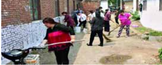
山城路街道办事处卫星街西段社区组织居民对金属制品厂家属院墙壁进行粉刷。
