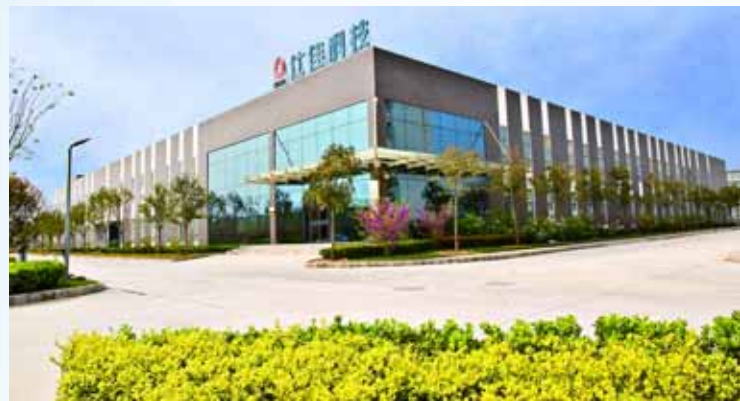
河南仕佳光子科技股份有限公司研发大楼
