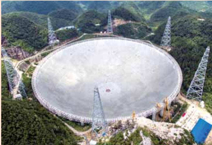
7月3日，位于贵州黔南州平塘县大窝凼的世界最大单口径射电望远镜——500米口径球面射电望远镜（FAST）主体工程顺利完工。据介绍，FAST突破了射电望远镜的百米极限，它拥有30个足球场的接收面积，与号称“地面最大的机器”的德国波恩100米望远镜相比，灵敏度提高约10倍。
