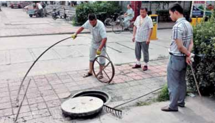
7月5日上午,淇滨区九州路街道鹤翔社区的工作人员在排查中发现,鹤翔西区1号、2号楼的化粪池堵塞,污水外溢,便立即安排人员进行疏通冲洗。图为工作人员准备用工具疏通化粪池。 本报记者 陈海寅 摄
