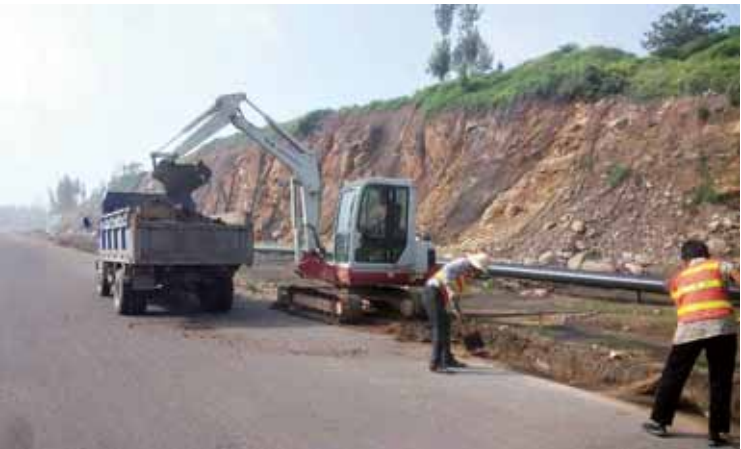
8月10日,宝山循环经济产业集聚区组织人员、车辆,集中清理辖区内主干道一侧边沟内的积土,对边沟进行疏浚。
