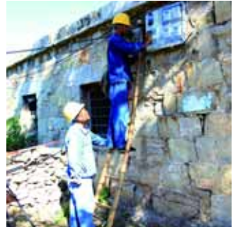
电力职工为农户安装新电表箱
