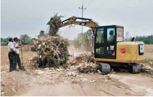
9月25日,鹤壁国家经济技术开发区渤海路办事处组织30余名工作人员,出动两辆挖掘机、1辆装载机,对通淇大道、冷虎线两侧的秸秆、垃圾、杂物进行集中清理,共清运垃圾、秸秆23车。
